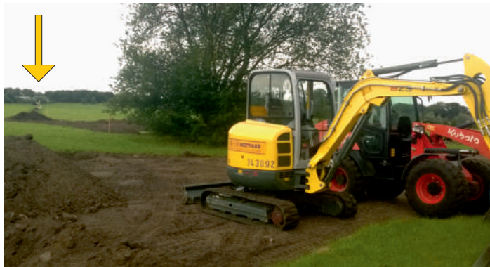
Na endlich, die Bauarbeiten am Generationenspielplatz in Banzkow haben begonnen. Auch die Störche interessiert offenbar, wie dort für den Nachwuchs gesorgt wird.
