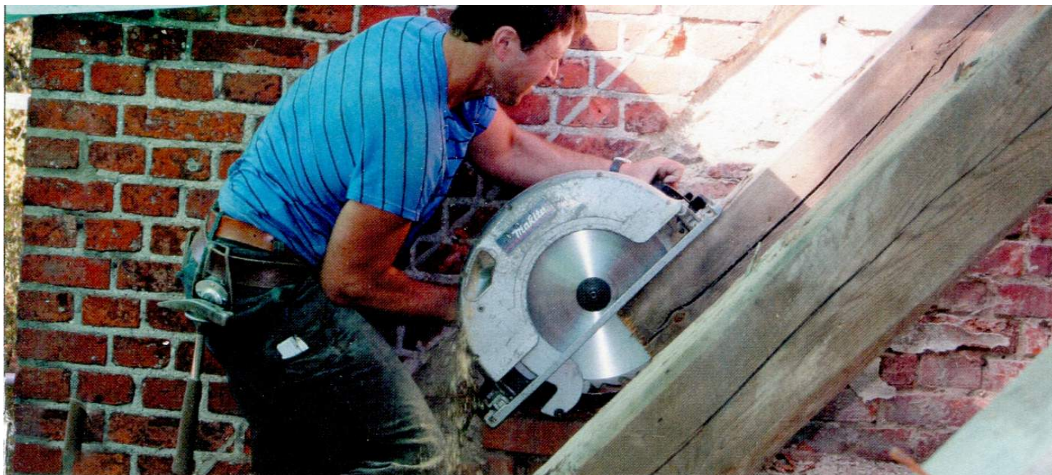
Die Sparrensanierung erfordert viel Kraft und Erfahrung
