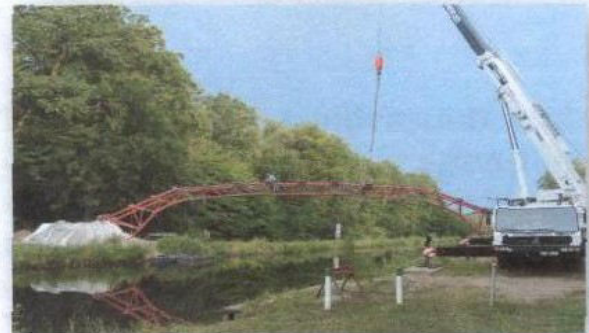
Am 27. Juli wird die Stahlrohr-Unterkonstruktion in die fertiggestellten Widerlager eingesetzt
