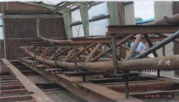
In der Werkstatt der Hydrotechnik Schlestein GmbH wird die Stahlrohrkonstruktion der Brücke angefertigt
