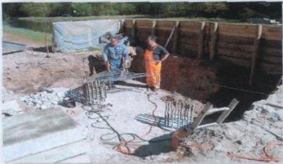
Die 9 m langen Oberflächengründungspfähle sind eingebracht
