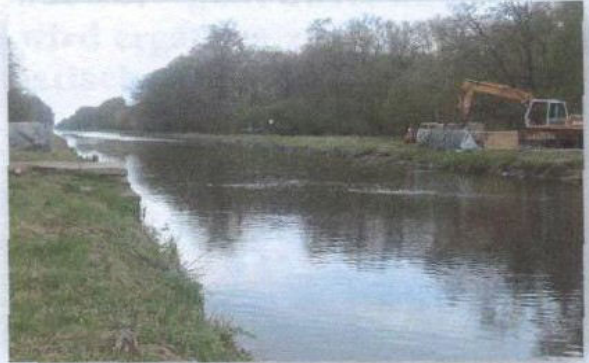
Bauarbeiten an den Widerlagern der geplanten Brücke
