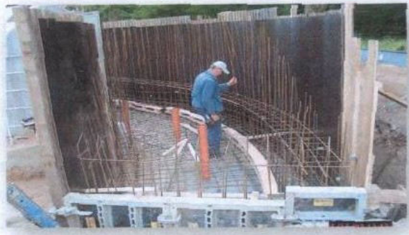
Viele Meter Bewehrungsstahl werden verarbeitet
