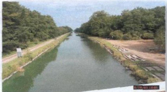
Den Bauarbeitern bietet sich nun ein schöner Blick auf den Störkanal
