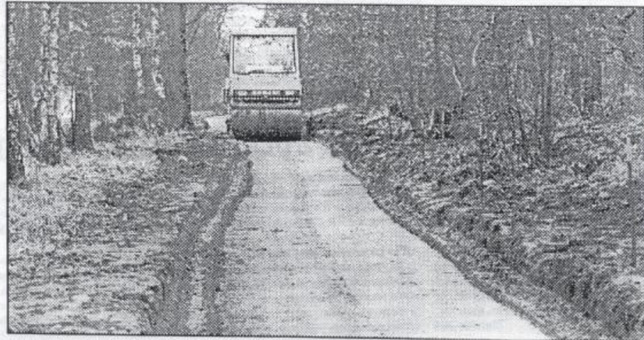
Der Bau des Radweges hat begonnen
