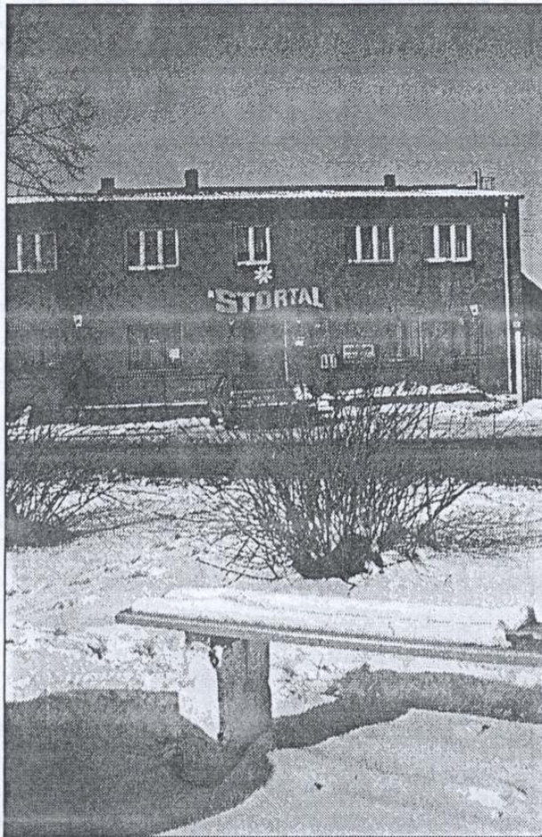
Ins „Störtal“ soll wieder Leben einziehen. Gegenwärtig wird von der Firma Stier die Heizung erneuert. Fotos: Rita Dechow
