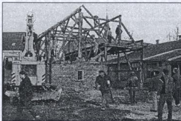
Das war so recht nach dem Geschmack der Banzkower Feuerwehrleute um Wehrlführer Manfred Dähn. „Baufällige Scheune am ‚Störtal‘ muß weg? Da fackeln wir nicht lange.“
