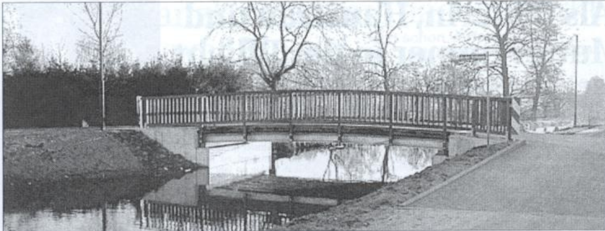
Die neue Brücke über den Mühlengraben wurde ihrer Bestimmung übergeben.
