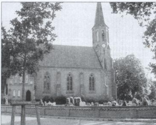
Zur Zeit gehört unsere Kirche den Bauarbeitern
