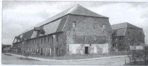
Denkmalgeschützte Scheune mit moderner Technik auf dem Dach.
