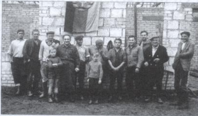
Viele freiwillige Helfer beim Bau der Kinderkrippe 1968/69.
