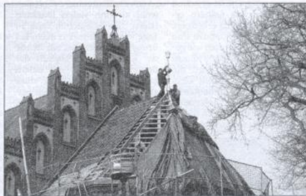
Die Dachdecker wurden tatkräftig von Mitgliedern des Förderkreises unterstützt.
