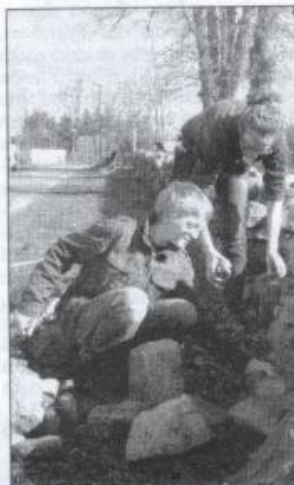
Friedhofsmauer, die an einigen Stellen eingefallen war, wieder aufzubauen.
