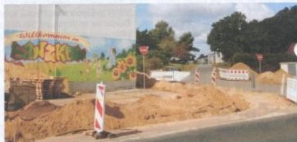
Die Trafostation an der Werkstatt der Apg Banzkow/Mirow wird neu verkabelt. Dazu musste die WEMAG einen neuen Kabelschacht ziehen.
