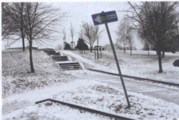
Die defekte Treppe wird abgerissen...
