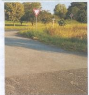
Asphaltausbesserung an der Tabakrocknung zur Freude der Radfahrer.
