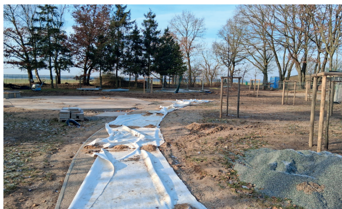
Das Fundament für das Grüne Klassenzimmer auf dem Schulhof wurde noch vor Weihnachten gegossen, bevor der Frost den Weiterbau stoppte.
