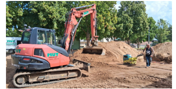
Die Firma MUT Kommunalbau hat im Sommer viele Kubikmeter Erde auf dem Schulhof bewegt.
